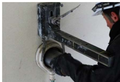
庁舎劣化診断(コア抜き)
