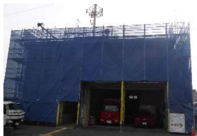
庁舎防水工事
